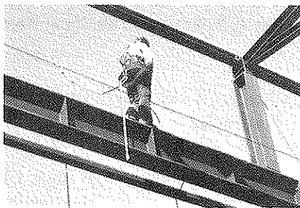
d. Wire infäst ca 1 m ovan stålbalk.
